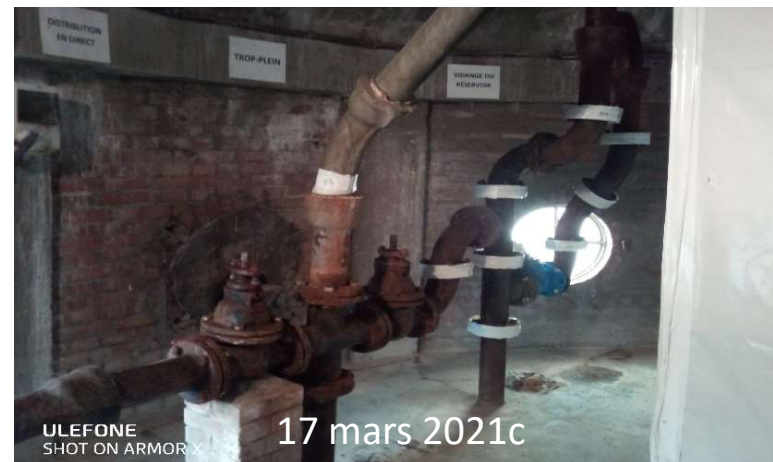
Tuyauterie après désamiantage
