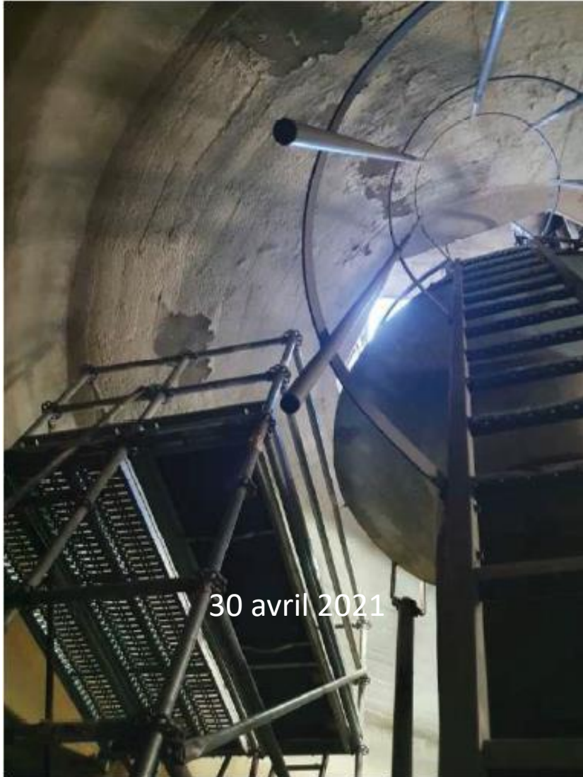
Echafaudage mis en place dans la cuve
