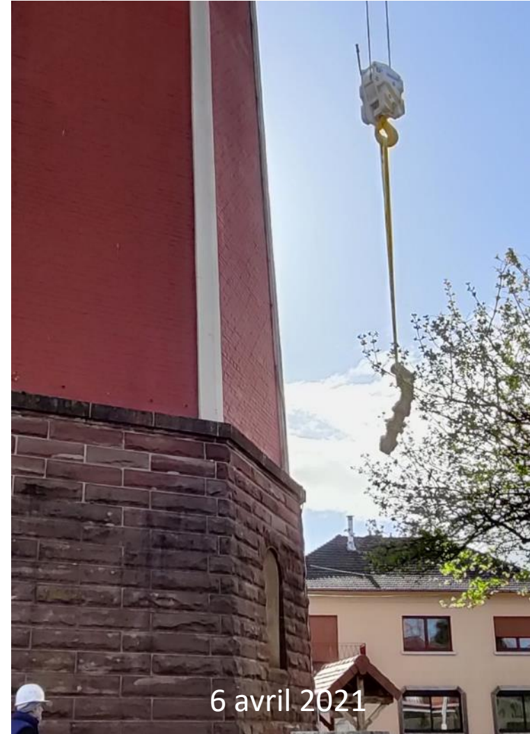
Les tuyauteries démontées sont retirées en passant par une trappe en place sur le toit du château d'eau
