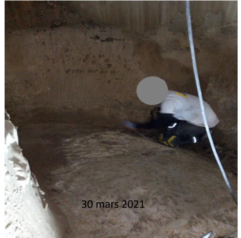
Décapage mécanique de la surface interne de la cuve
