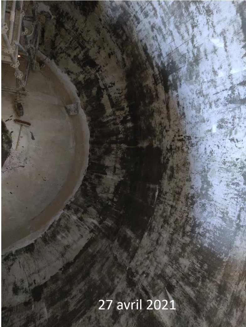
Ragréage et application de l'enduit primaire d'accrochage à l'intérieur de la cuve
