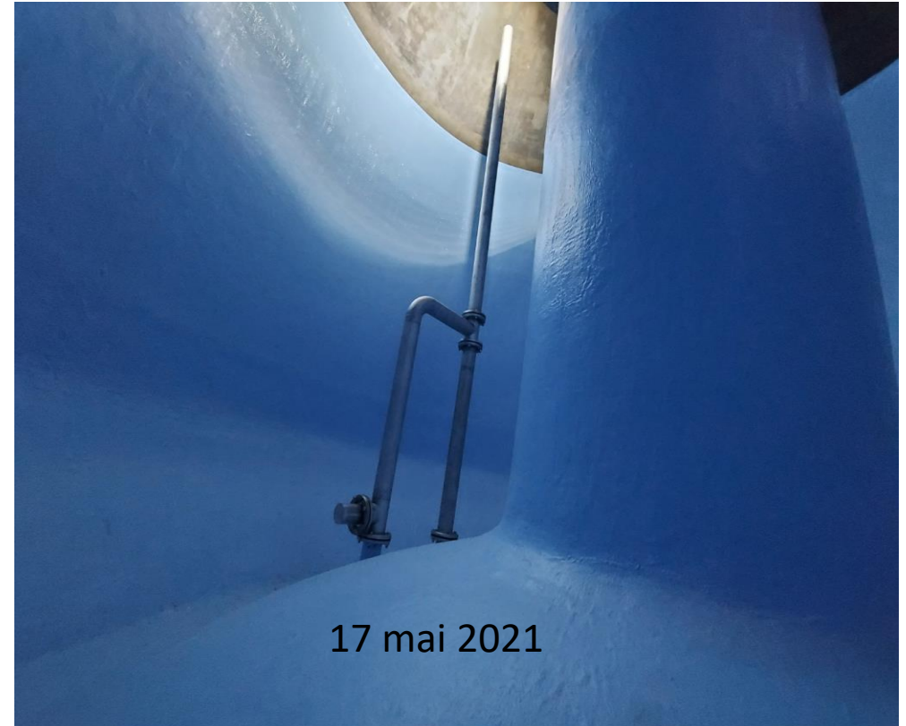
Cuve équipée avant désinfection et remise en eau du réseau
