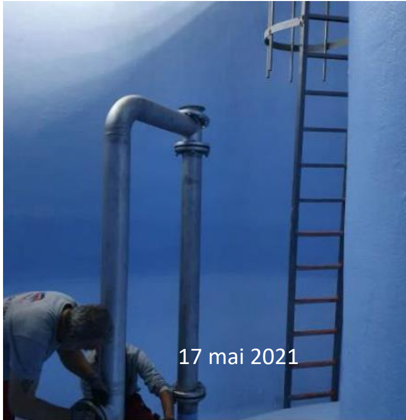
Montage de la nouvelle tuyauterie inox à l'intérieur de la cuve de 200 m3
